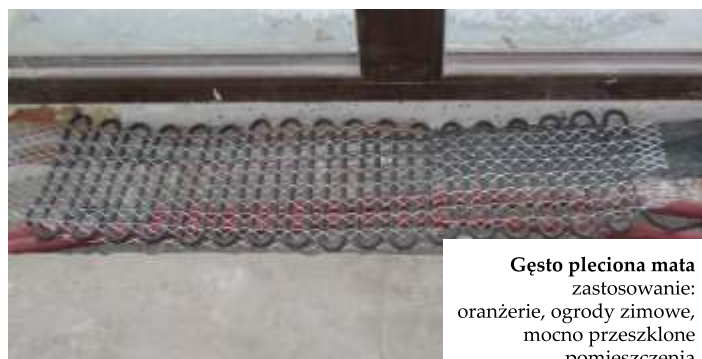
Szybki montaż (gotowa rolowana mata)
